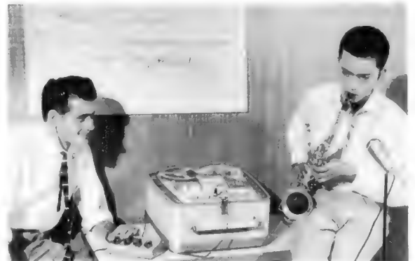
Bild 2. So kann die Sache in der Praxis aussehen; erfahrungsgemäß ist es jedoch günstiger, den „Künstler“ mit seinem Mikrofon in einen Nebenraum zu placieren, während der „Tonmeister“ mit dem Gerät im Regieraum verbleibt
