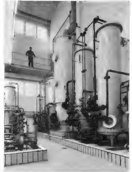
Bild 2. Große Anlagen für winzige Erzeugnisse: Diese Wasseraufbereitungsanlage für die De-Ionisierung und Vollentsalzung scheint eher in eine chemische Fabrik zu gehören
