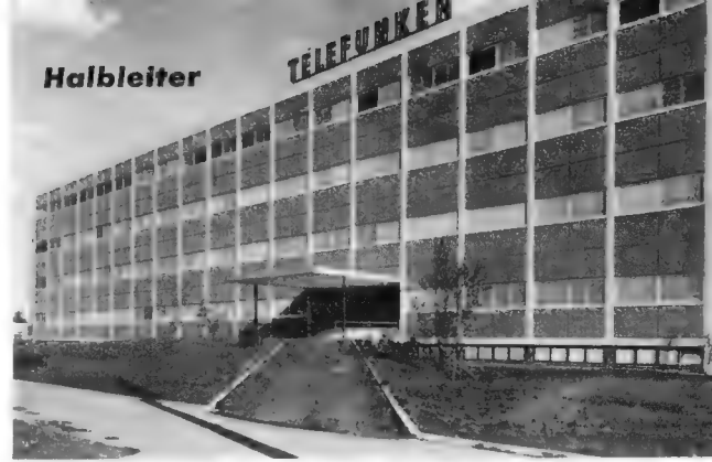
Bild 1. Das Hauptgebäude des neuen Telefunken-Halbleiterwerkes Heilbronn vereint Zweckmäßigkeit mit architektonischer Schönheit
